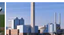
Tiefstack CHP Hamburg / Germany
